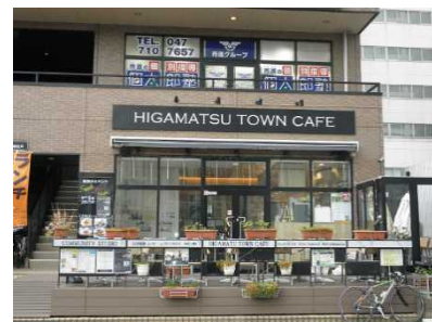
正面にカフェ、奥にスタジオを配置したコミュニティ施設
