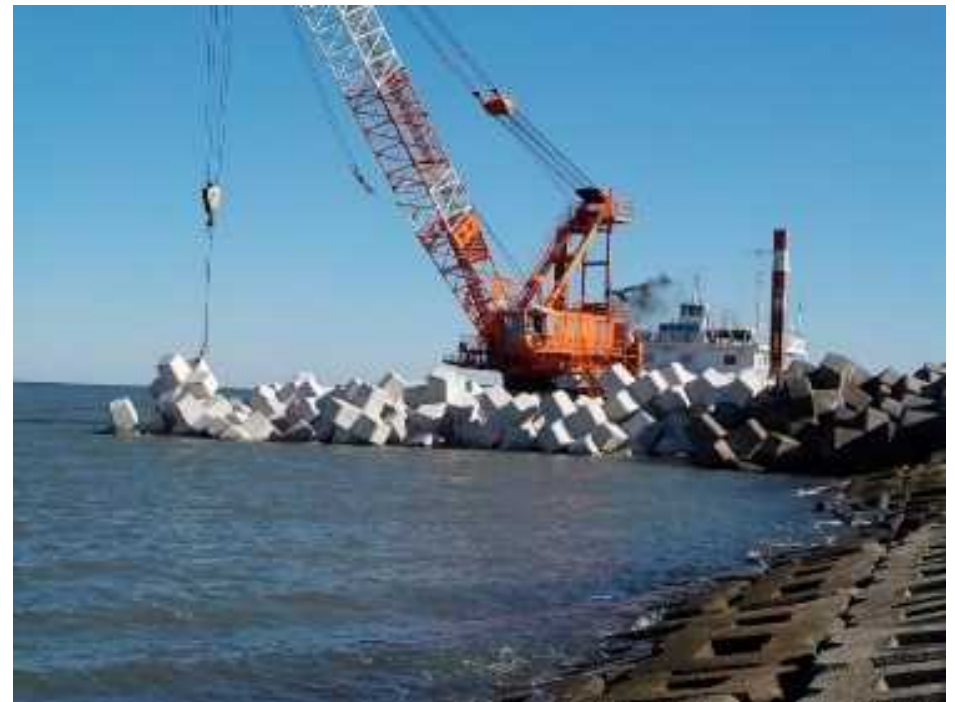
ヘッドランド施工
