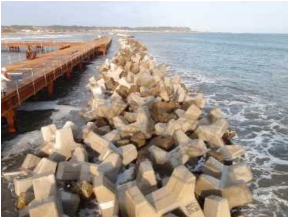
離岸堤施工
