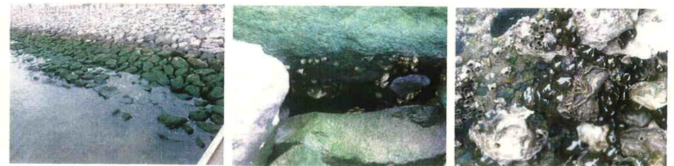
千葉港海岸習志野地区 石積護岸(勾配3割) 施工後約1年半経過
