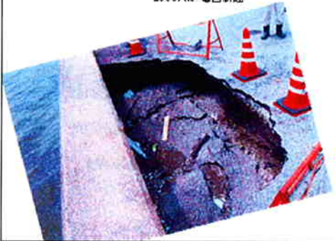
穴は老朽化で陥没してきた＝市川市塩浜1の暫定護岸で
