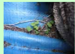
土嚢の基盤を囲む不透水性シート(壁側の“横面”には穴が空いている、土嚢の“下面”には穴がない)
