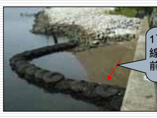
H21年9月4日(施工後2ヵ月半) 撮影時潮位A.P.+0.5m程度
