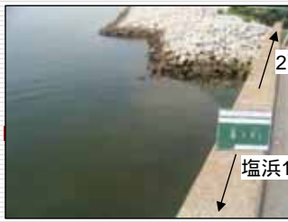
H21年6月12日(施工前)
