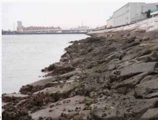
1工区石積み護岸低～中潮帯付近の状況
