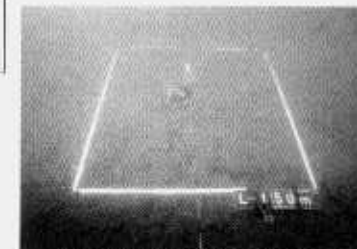
50m地点、滞筋の底部 浮泥が厚く堆積する。
