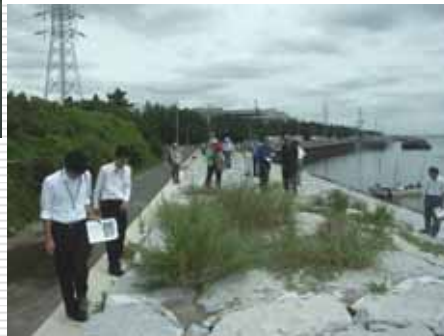
石の間詰めによる試験箇所
