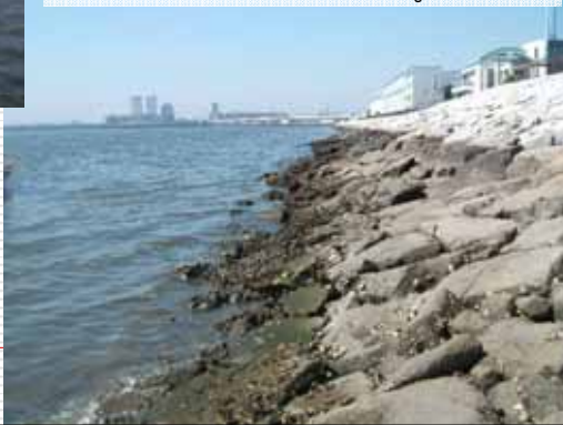
1工区石積み護岸中潮帯付近の状況
