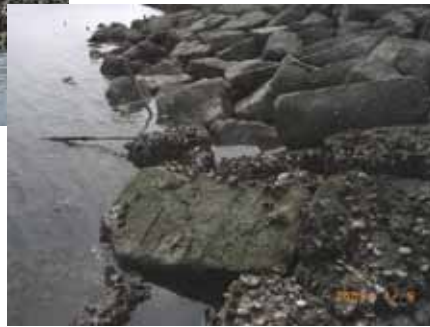
1工区石積み護岸のり先の状況
