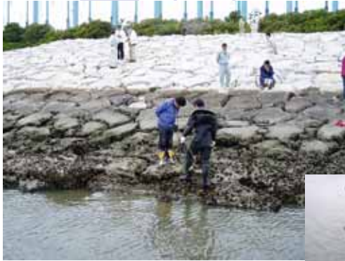
1工区石積み護岸の状況
