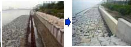
上部工 (H鋼杭 + 鋼矢板 : 100m)
