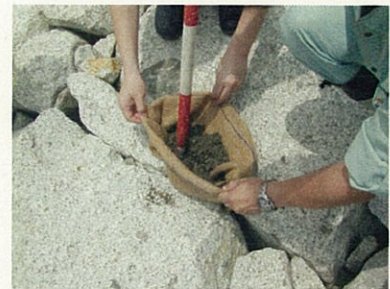
3) 砂の締め固め
