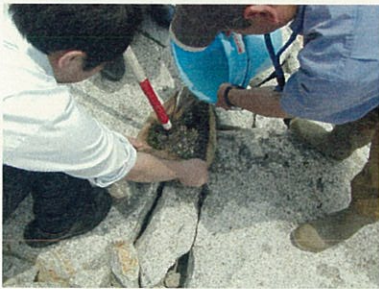
4) 水締め・砂の補充 (繰り返し)
