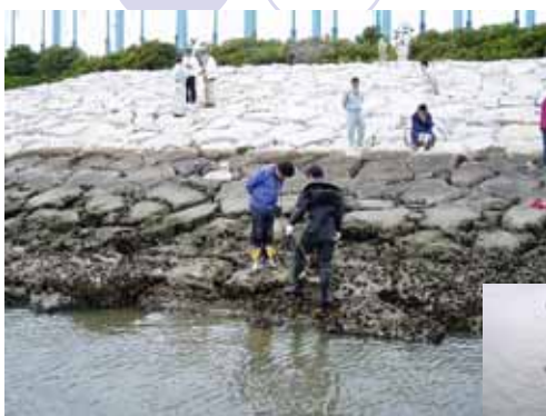
1工区石積み護岸の状況
