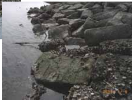
1工区石積み護岸のり先の状況
