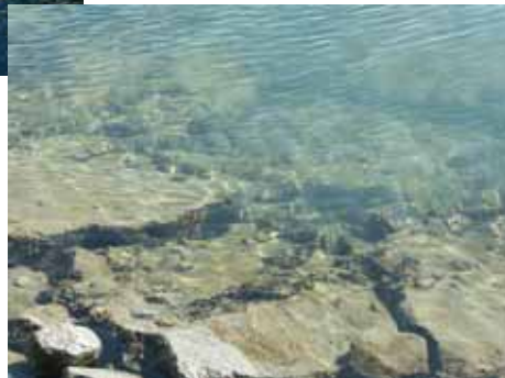
1工区石積み護岸のり先の状況
