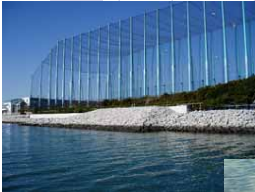
1工区石積み護岸の状況
