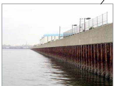
改修前の直立護岸
