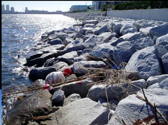
1工区乱積み部の状況
