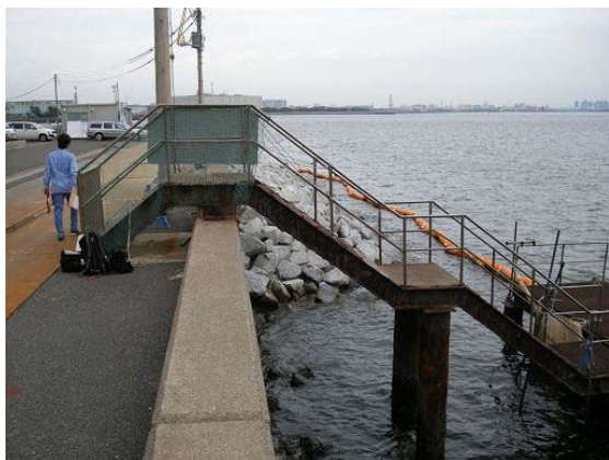
棧橋東側階段 平成 24 年 7 月 3 日撮影
