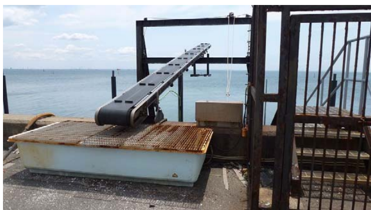
ベルトコンベア全景 平成 24 年 5 月 12 日撮影
