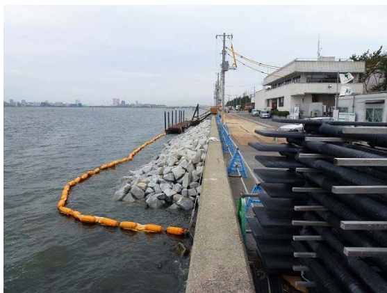
棧橋全景（西側を臨む） 平成 24 年 7 月 3 日撮影
