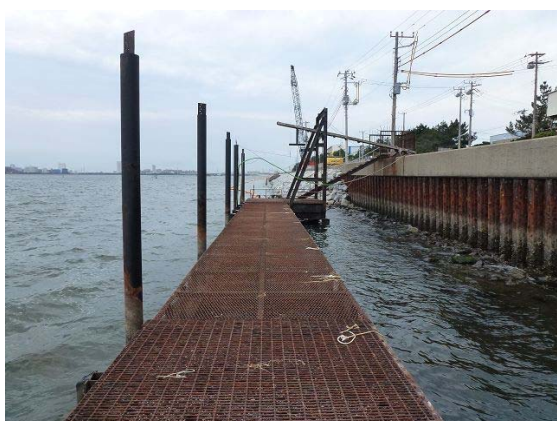
棧橋デッキ部（西側を臨む） 平成 24 年 7 月 3 日撮影
