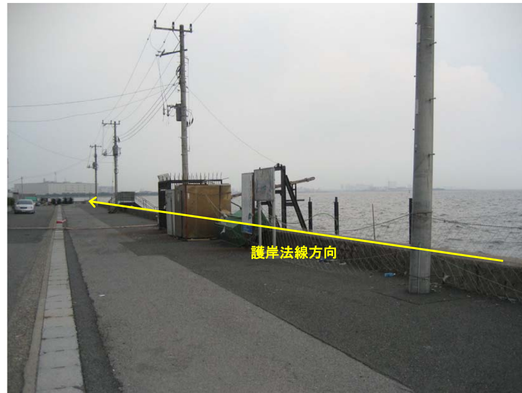
① 護岸の法線方向に端部を臨む
