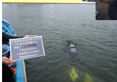
水面下での調査状況
