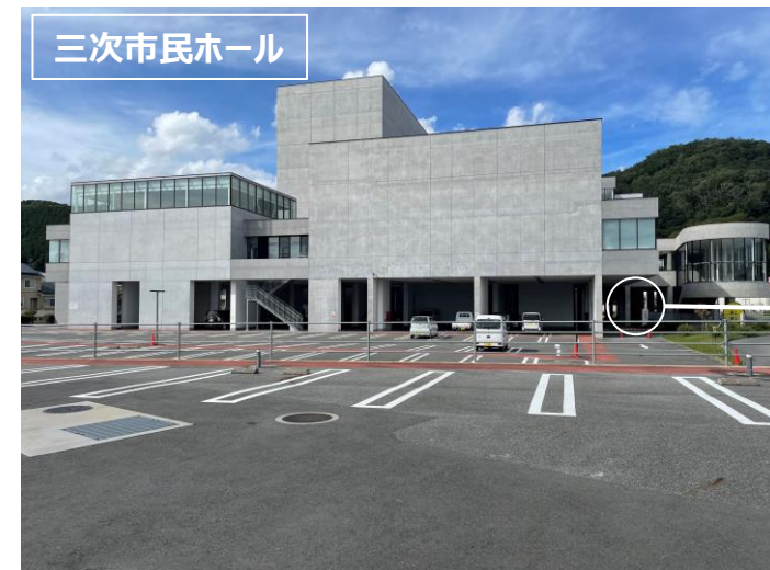
三次市民ホール（地面から5m持ち上げたピロティ構造）
