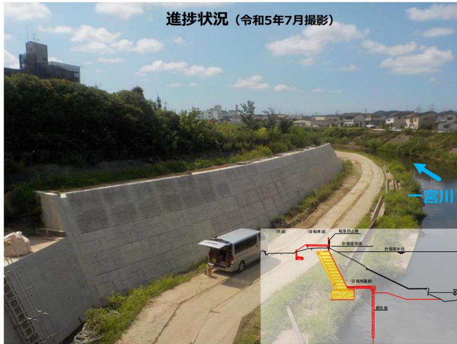
護岸法立て区間（旭橋下流）
