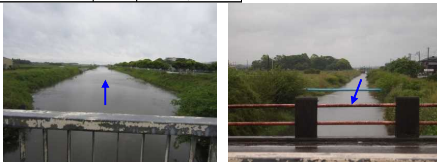
治水基準点の中橋より改修済みの下流と未改修の上流を望む。河道拡幅に合わせて、中橋も架け替えを予定している。(平成27年5月19日撮影)
