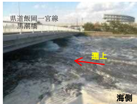
■ 真亀川河口部を遡る津波 (第1波の遡上状況)
