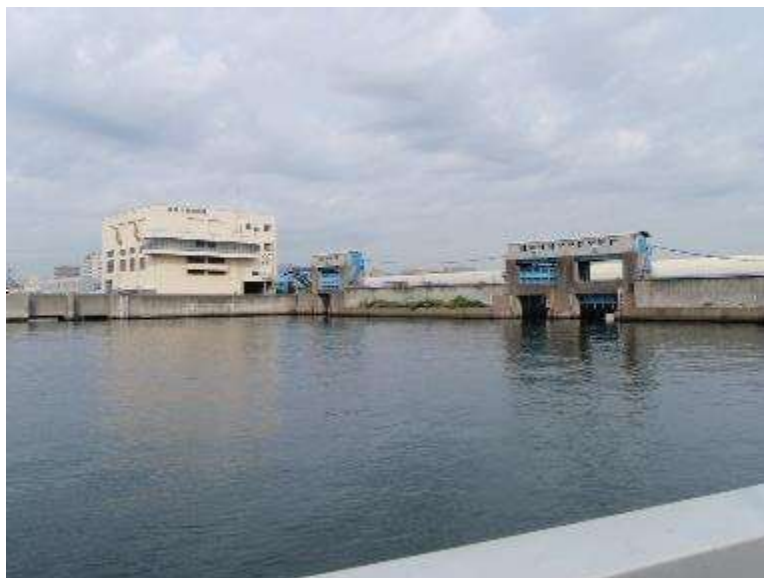
海老川排水機場
