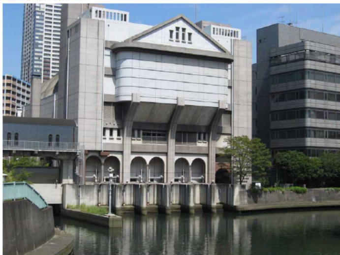
葭川排水機場(下流側から)
