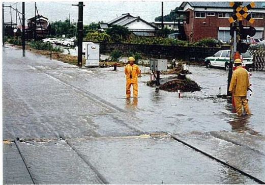
H8. 9/22 洪水 (JR 線路の冠水状況)
