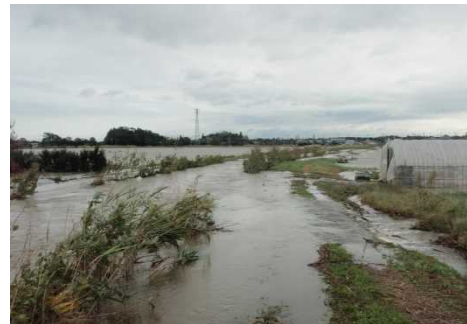
H25. 10/16 洪水 (河川からの氾濫状況)
