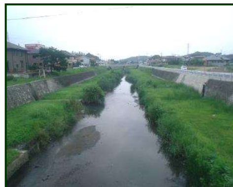
砂子橋より上流側の現在の状況
