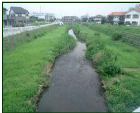
川間橋より下流側の現在の状況
