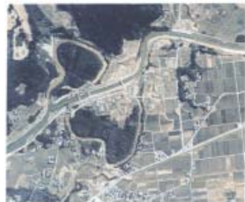
改修後河況状況（養老川：市原市上流地先）
