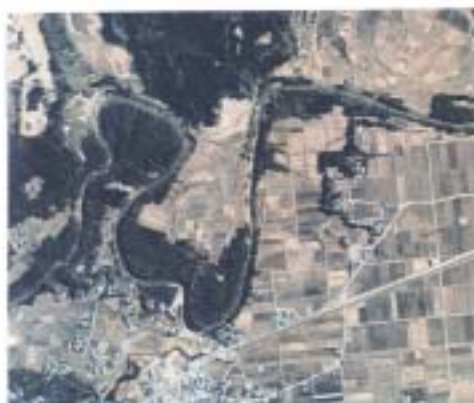
改修前河況状況（養老川：市原市上流地先）
