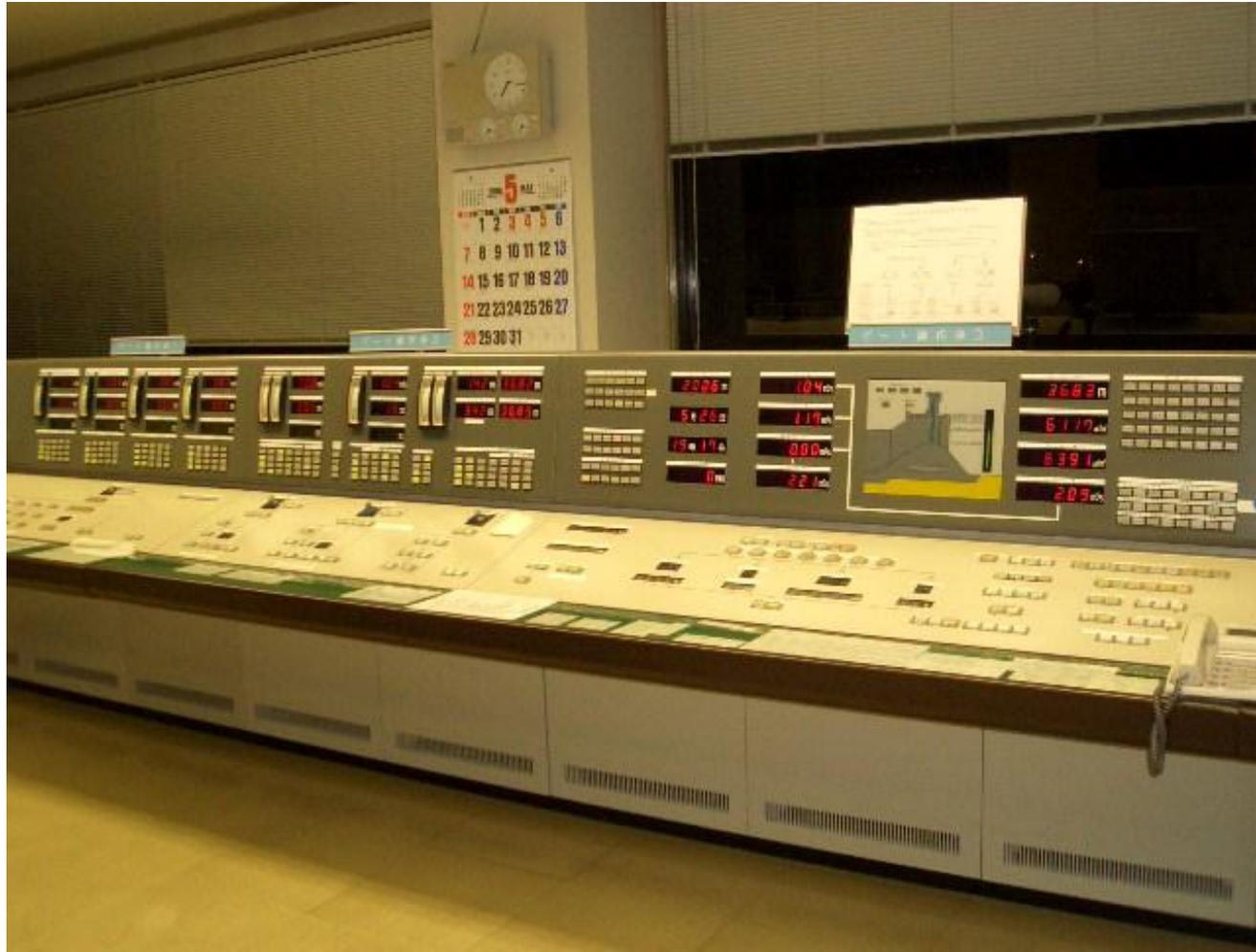
ダムコンピュータは、雨量、水位のデータからダム流入量と放流量を計算し、操作員の操作を支援するとともに、ゲートなどの放流設備を制御する設備です。
