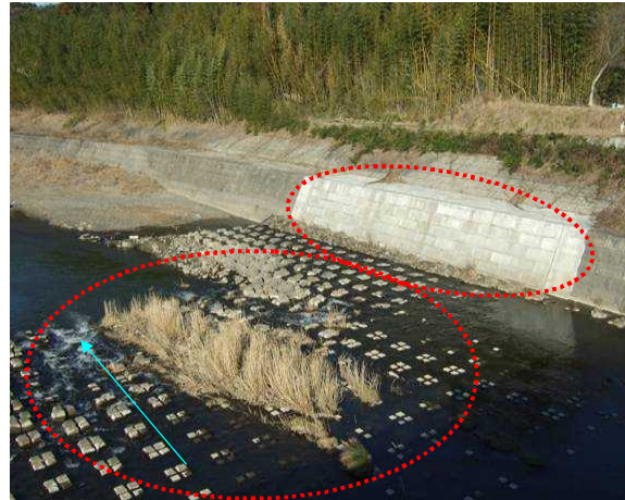
復旧後 平成21年
