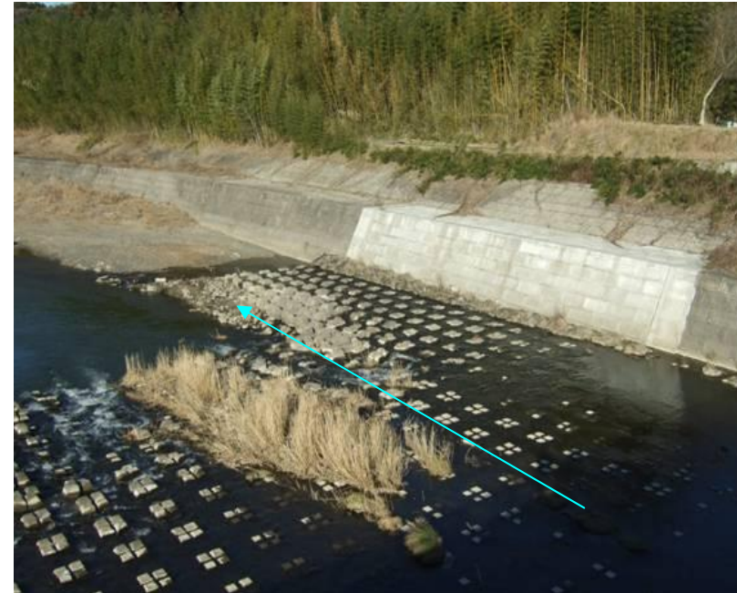
復旧後 平成21年
