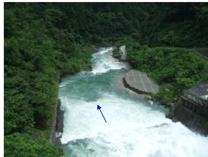
ダム放流による置土の流出
