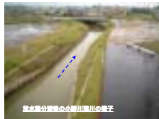
放水部分埋塞の小野川利根川の様子
