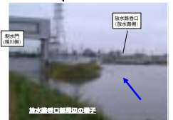
放水路出口付近の様子
