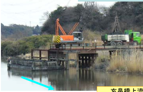
亥鼻橋上流部
