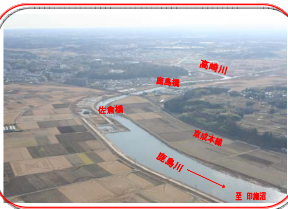
(鹿島川) 平成19年1月
