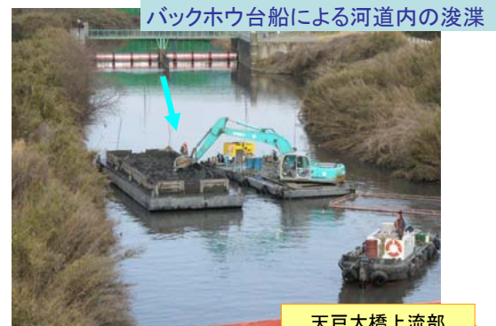
天戸大橋上流部
