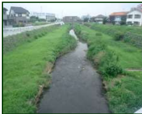
川間橋より下流側の現在の状況
