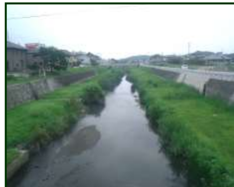
砂子橋より上流側の現在の状況
