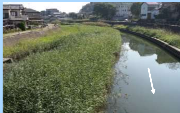
椎津川の河川状況(姉崎橋上流)
