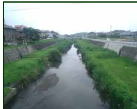
砂子橋より上流側の現在の状況
