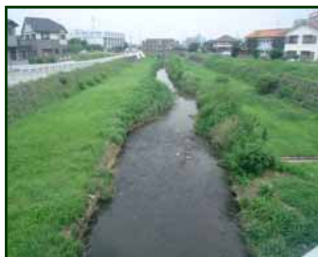
川間橋より下流側の現在の状況
