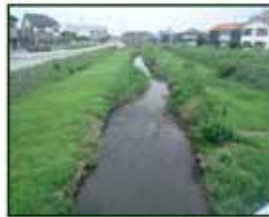
川間橋より下流側の現在の状況
