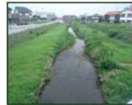
川間橋より下流側の現在の状況
