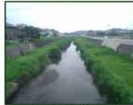
砂子橋より上流側の現在の状況
