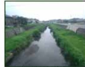
砂子橋より上流側の現在の状況
