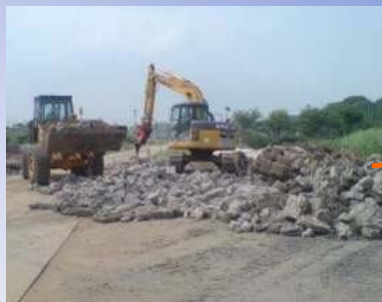
既設護岸等のコンクリート塊を再利用した根固め工
