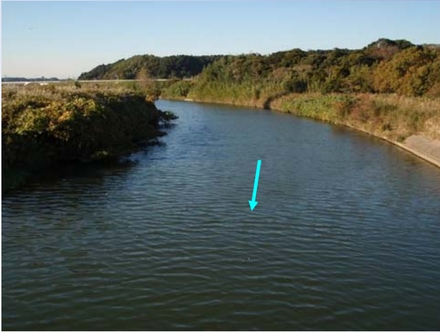
新栗山橋上流部
