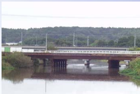
鋼材の再利用により建設した 栗山橋迂回路仮設橋
