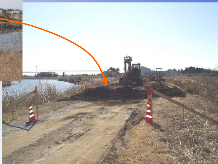
掘削土を再利用した築堤整備状況
