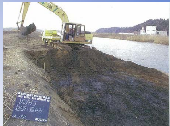
河道掘削状況2
