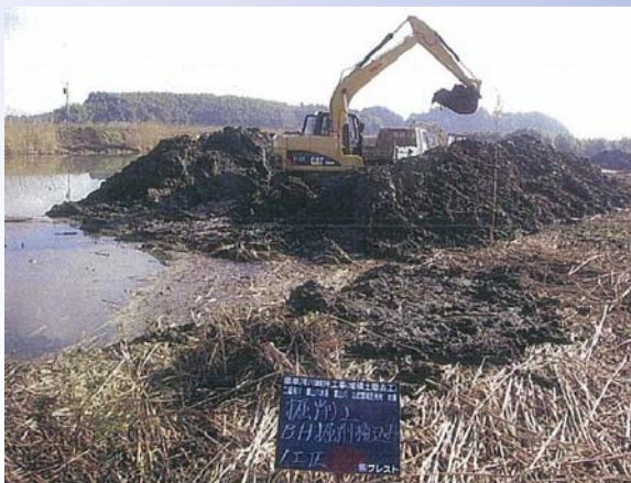
河道掘削状況
