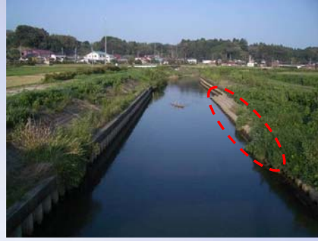
河床低下対策(護岸補強)として 実施した根固工 (小池谷橋下流)
