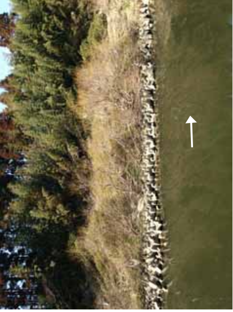
・万木橋の下流側（左側・左岸） ・根固めブロックにヤナギがついており、河岸を守っている
