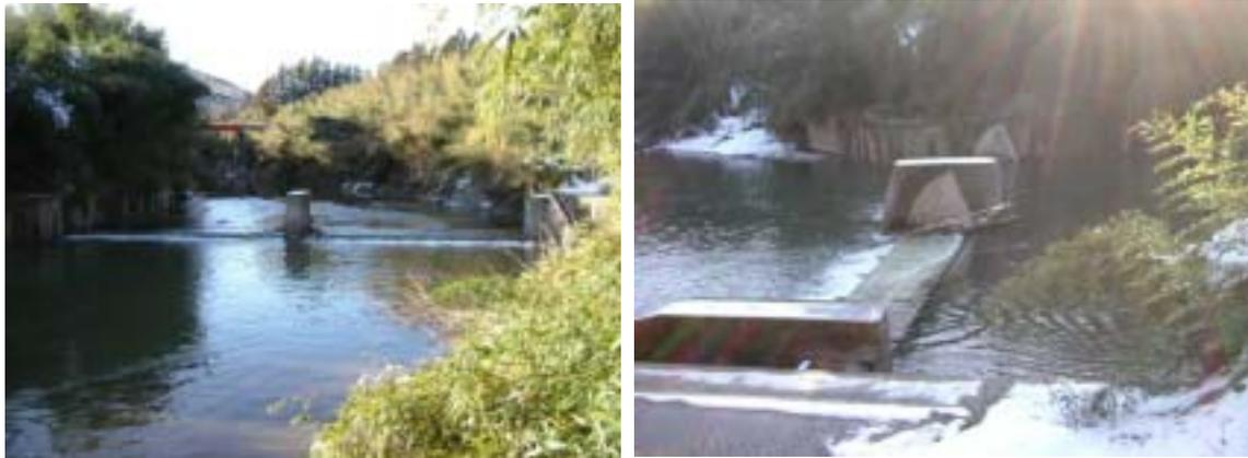
苅谷堰は農業用施設で、用水確保のために建設された可動堰である。その堰高は 2.3m である。
