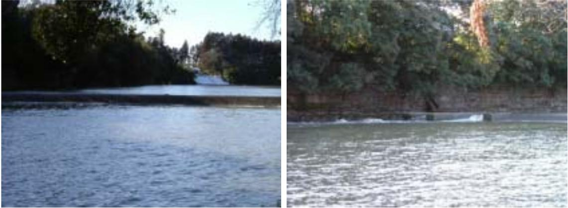
桑田堰は、今から 90 年前、大正時代に竣工したものとされている。この堰は、上流への潮止めの機能を有するとともに、堰上げにより農業用水を取水するためのものである。堰高は 1.7m である。
