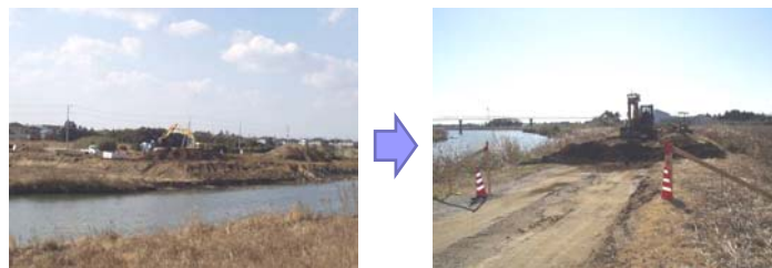
掘削土を再利用した築堤整備状況
