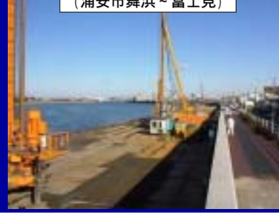
地盤改良工事の状況 (浦安市舞浜～富士見)
