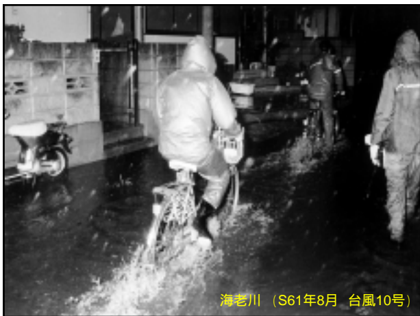
海老川 京成電鉄橋梁 (S61年8月 台風10号)
