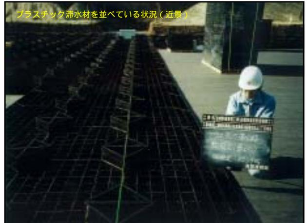
プラスチック滞水材の敷設完了（埋戻し直前）
