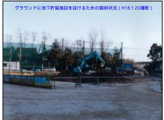
グラウンドに地下貯留施設を設けるための掘削状況（H18.1.20撮影）
