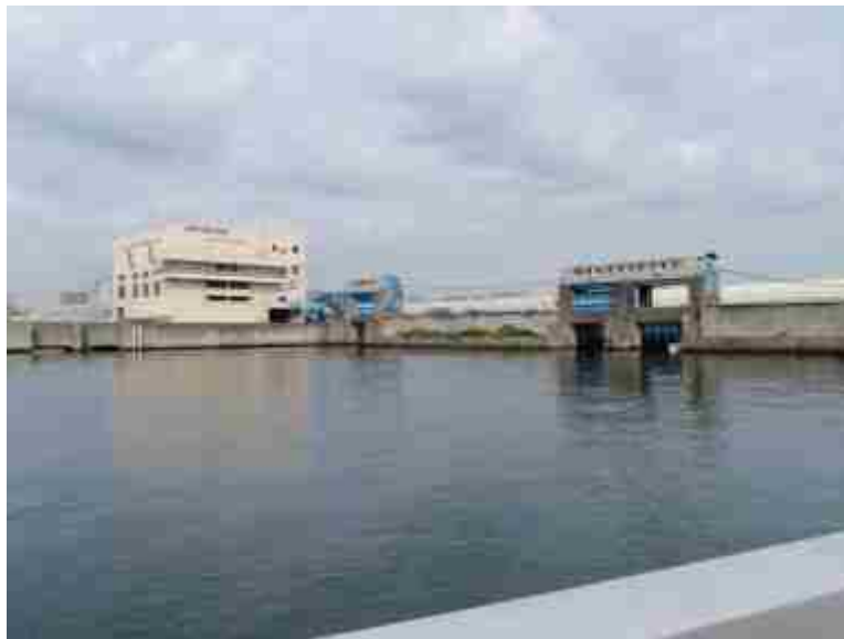
海老川排水機場
