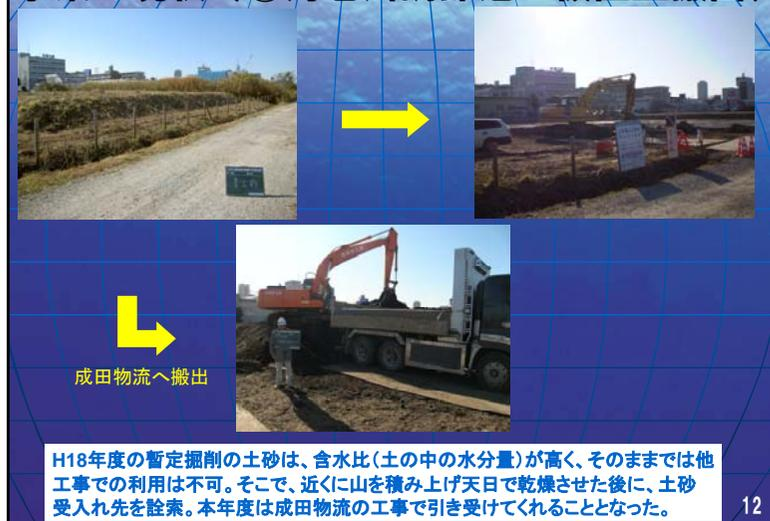
H18年度の暫定掘削の土砂は、含水比(土の中の水分量)が高く、そのままでは他工事での利用は不可。そこで、近くに山を積み上げ天日で乾燥させた後に、土砂受け入れ先を探索。本年度は成田物流の工事で引き受けてくれることとなった。
