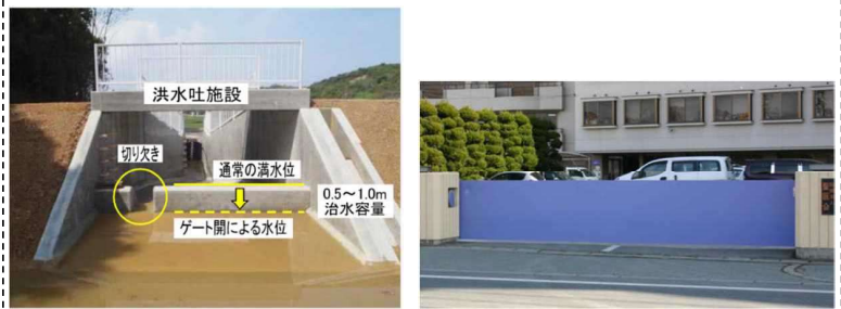
指定貯水施設(ため池)での 事前放流施設整備の事例
