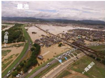
おだがわ ⑤小田川における浸水被害 (岡山県倉敷市)
