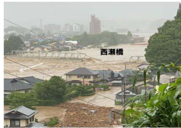
くまがわ ⑩球磨川における浸水被害状況 (熊本県人吉市)
