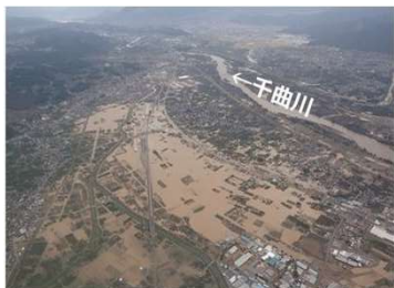
ちくまがわ ⑨千曲川における浸水被害状況 (長野県長野市)
