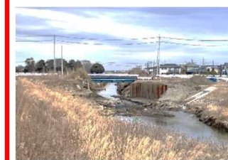
橋梁改築（中橋）
